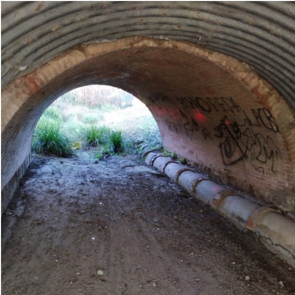
Ampliació de l'obra de fàbrica aigües avall
