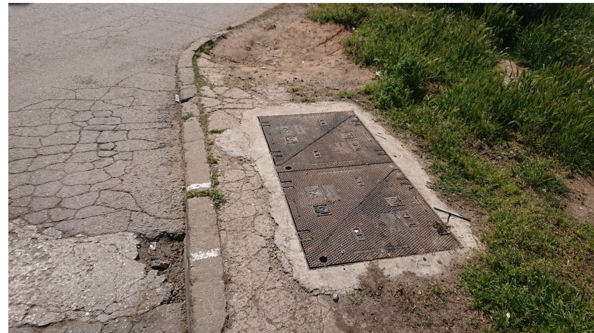
Presència de canalització soterrada de telecomunicacions
