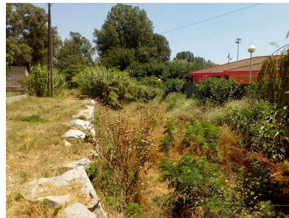
Figura 16. Escullera al marge esquerre del torrent d'en Bosc, vist cap a aigües avall.
