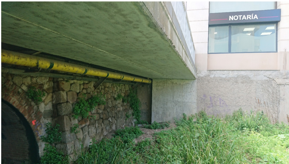
Pas sota Anselm Clavé, aigües amunt. Vorera ampliada amb una estructura d'estreps de formigó i plaques prefabricades, exempta de l'estructura original
