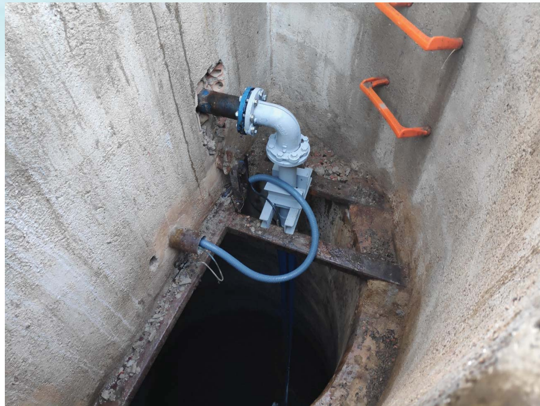
Figura 25. Suport de la bomba del pou.
