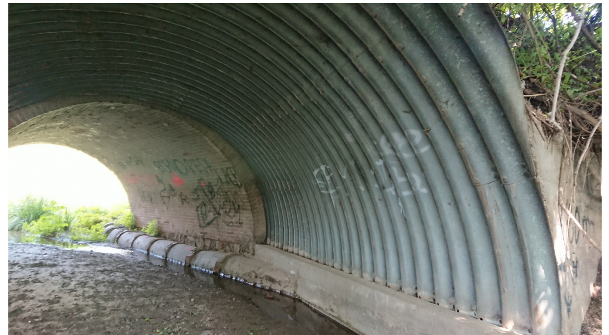
Ampliació del pas inferior, exempt de l'estructura original, mitjançant un encofrat perdut de xapa ondulada
