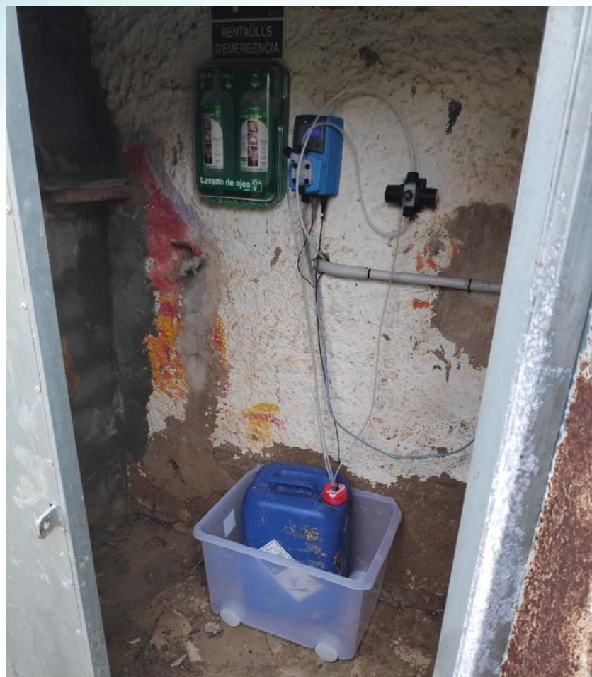
Figura 23. Visió del sistema de desinfecció per injecció de clor.
